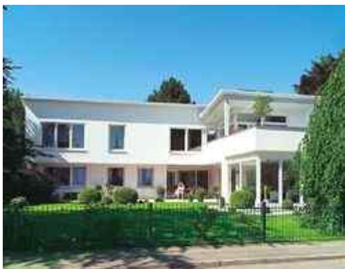
Grandioser Unterschied – der Flachdachbungalow nach der Erweiterung
