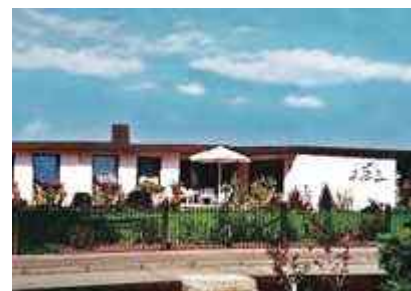
Grandioser Unterschied – der Flachdachbungalow vor der Erweiterung
